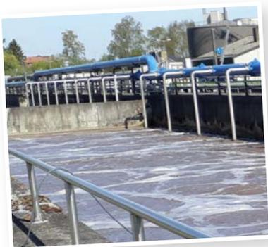
Heute züchtet man diese Bakterien und kleinen Tierchen in Kläranlagen, damit sie für uns den Schmutz aus dem Abwasser auffressen. Damit sie sich besonders wohl fühlen und gut vermehren, wird Luft in das Wasser geblasen. Man nennt diese Becken **Belebungsbecken** (Foto links). In unserem Experiment würde man so den Zucker aus dem Wasser herausbekommen, weil die Bakterien und kleinen Tierchen ihn auffressen würden.
